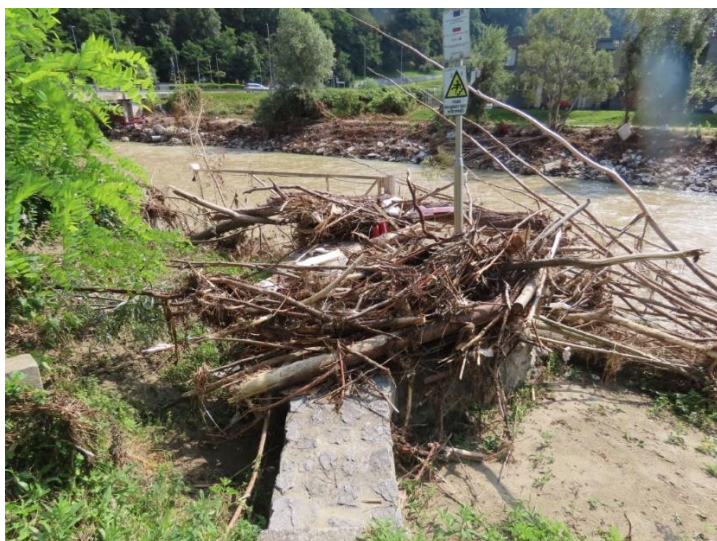
Slika 14. V avgustovskih poplavah uničena vodomerna postaja Otiški vrh na Meži Figure 14. The water gauging station Otiški vrh Meža was destroyed in the August floods
