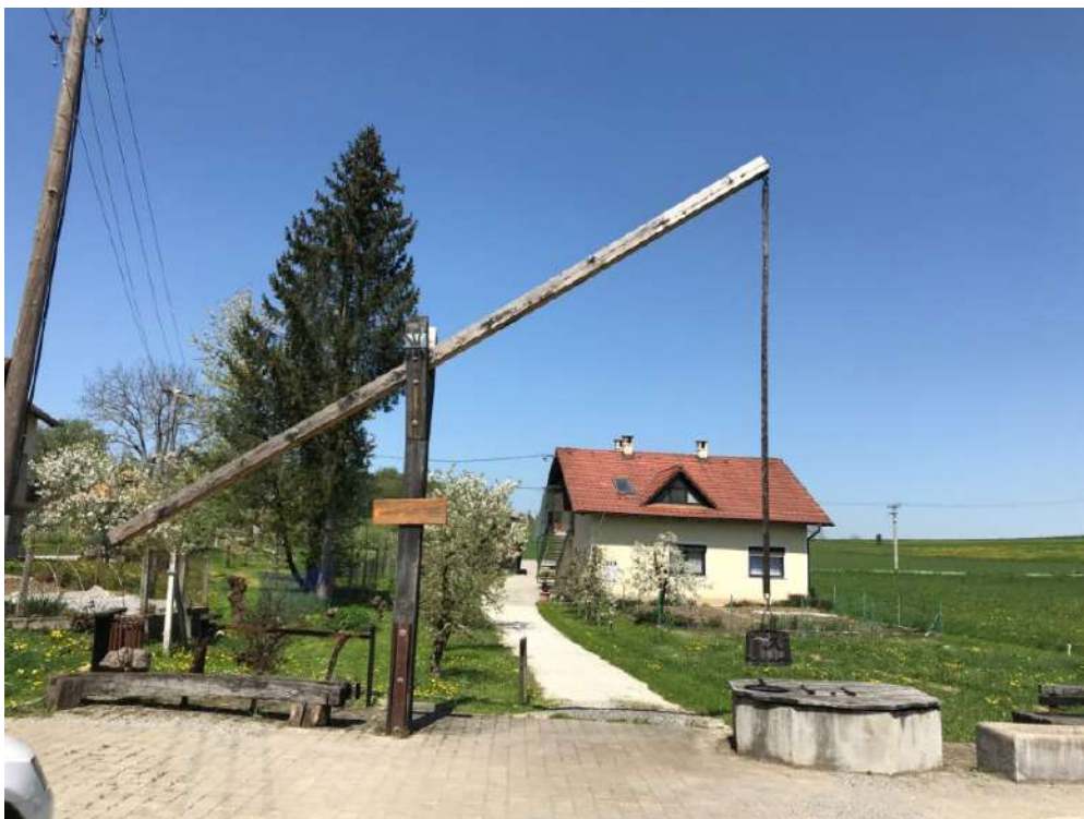
Slika 2. Šaduf v Gorenji vasi pri Šmarjeti je vodnjak na vzvod, ki se je v prejšnjem stoletju uporabljal na širšem območju Slovenije, njegov izvor pa sega v Egipt, kjer ga predvsem za potrebe namakanja uporabljajo še danes. Figure 2. Shadoof in Gorenja vas near Šmarjeta is a water well lever, which was used in last century on a wider area of Slovenia and originates from Egypt, where it is still used today as an irrigation tool.
