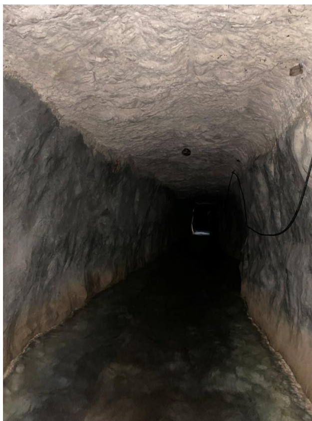
Slika 1. Vodni rov Mežica – Podzemlje Pece, 25. maja 2023 (Foto: U. Pavlič) Figure 1. Water tunnel Mežica – underground of Peca mountain on 25 th May 2023 (Photo: U. Pavlič)
