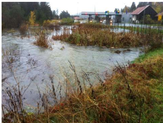
Slika 2. Med 6. do 8. novembrom je bil mejni prehod nad Babnim poljem delno zaprt. Voda je v tem času poplavljala cesto in posamezne objekte v Bukovici na Babnem polju (foto: krajan Prezid-a) Figure 2. The flood at the state border near Babno polje
