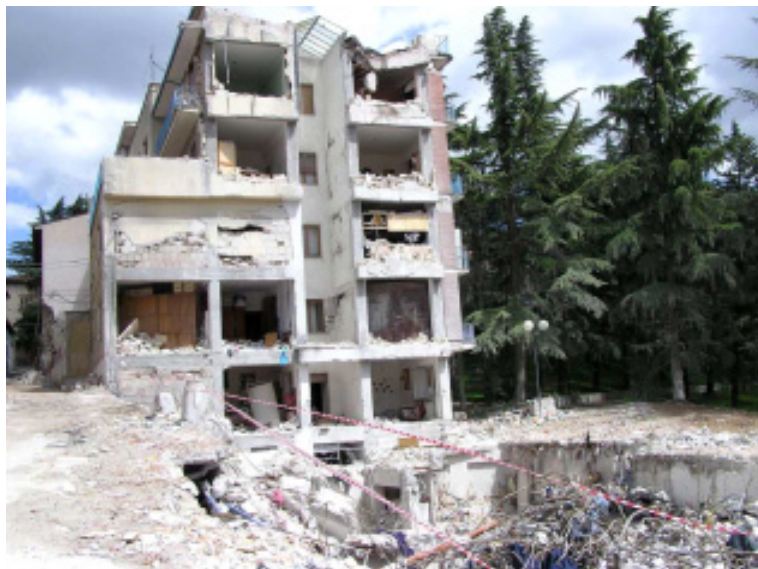
Slika 3. Poleg poškodovanega petnadstropnega bloka v širšem centru L'Aquile je stal še eden, ki se je popolnoma porušil (foto: I. Cecić) Figure 3. Damaged 5-floor block beside the completely collapsed one in the center of L'Aquila (Photo: I. Cecić)
