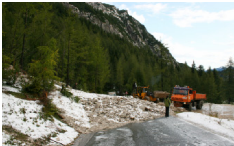
Slika 24. Sanacija plazu pod Vršičem, 5. september 2009 (foto: Jaka Ortar)
