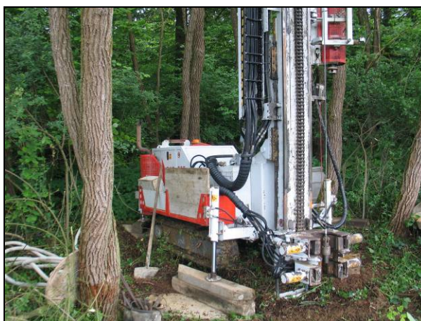
Slika 3: Vrtalna garnitura GEO 305, s katero sta bila izvrtana opazovalna piezometra NMPz-1/10 in NMPz-2/10.
