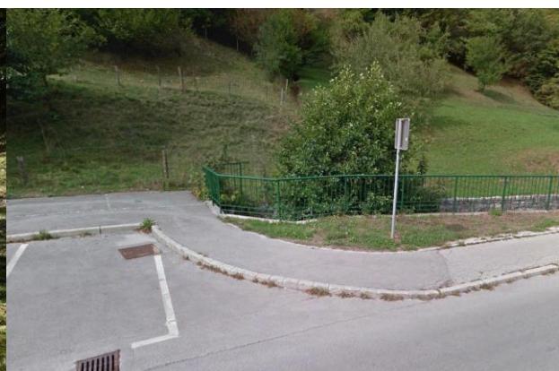
Slika 17: Potok Veriželj dolvodno od parkirišča pri pokopališču Velenje, ko pride na površje
