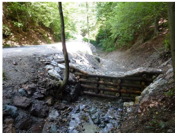
Slika 45: Pregrada na Hudem potoku (lokacija: dolvodno od vzorčevalnega mesta)
