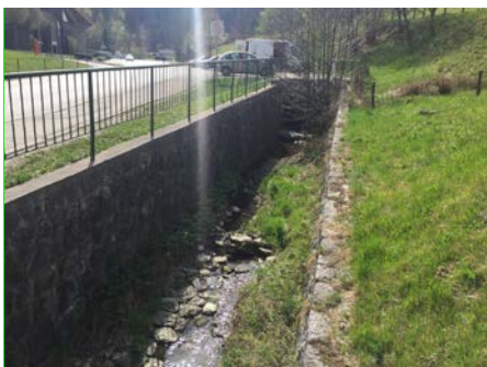
Slika 2: Regulirana struga na območju parkirišča pri pokopališču
