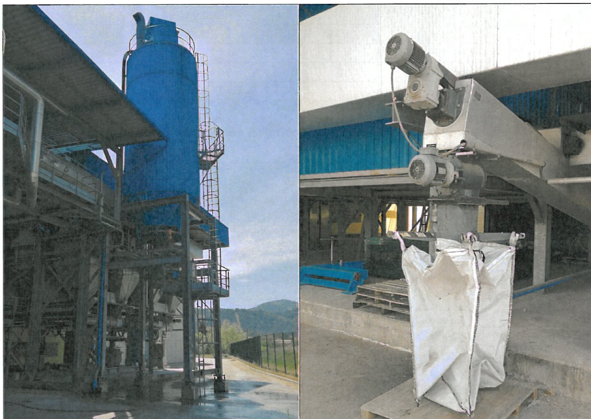
Slika 81: Namenski silos (nevarnega) pepela, ki omogoča neposredno praznjenje v cisterno transportnega vozila (levo) in big-bag vreča s procesnim aktivnim ogljem (desno) [vir: EIMV]
