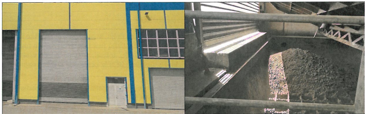
Slika 80: Sprejemnica za blato iz čistilnih naprav komunalnih odpadnih vod [vir: EIMV]
