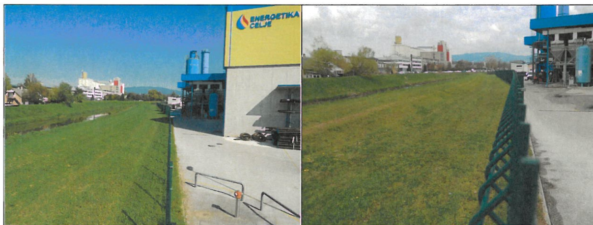
Slika 33: Območje med vodnim zemljiščem levega brega reke Hudinje in ograjo Toplarne Celje [vir: Toplarna Celje]
