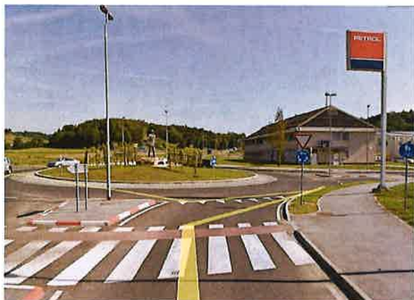
Slika 1: Krožišče v Lenartu, urejena kolesarska steza, R2-449/0315
