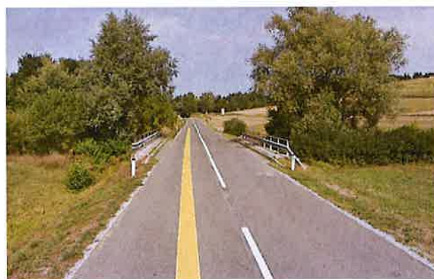
Slika 2: Obstoječa premostitev na R2-433, ki ne zadostuje umestitvi kolesarske poti.
