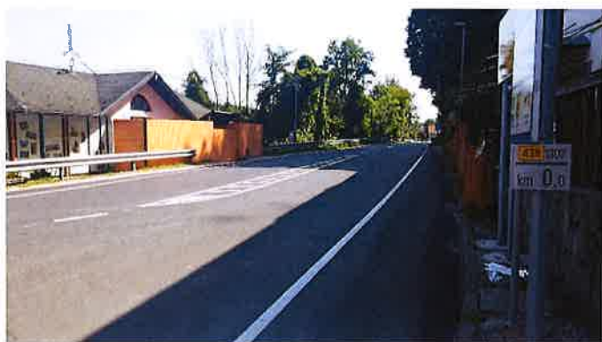
Slika 1: Začetek pri MP Trate. Levo reka Mura, desno oporni zidovi in objekti.
