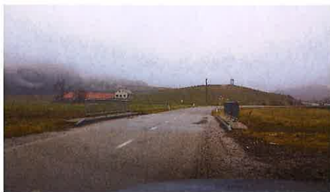
Slika 3: Premostitveni objekt na regionalni cesti proti Brengovi.
