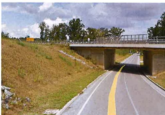
Slika 1: Nadvoz AC Lormanje, souporaba manj prometnega podvoza.
