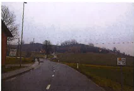
Slika 1: Začetek trase pri mostu čez potok Globovnica.
