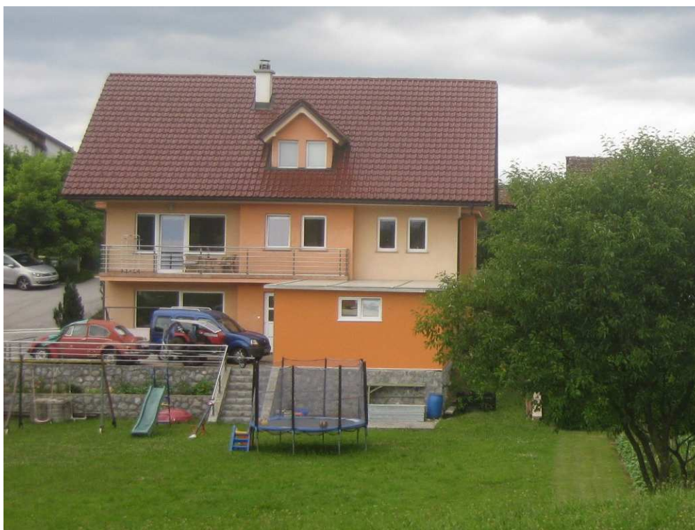
Fotografija 1: Pa01 – stanovanjska stavba Šegova ulica 118, Novo mesto
