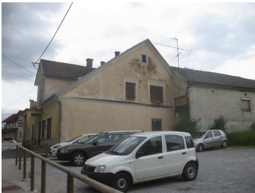
Fotografija 6: Pa07 – stanovanjska stavba Šmihel 12, Novo mesto
