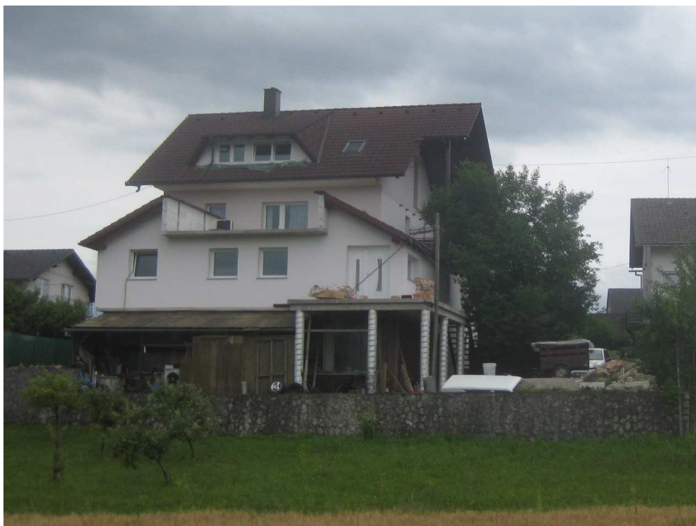
Fotografija 4: Pa04 - stanovanjska stavba Bajčeva ulica 8, Novo mesto
