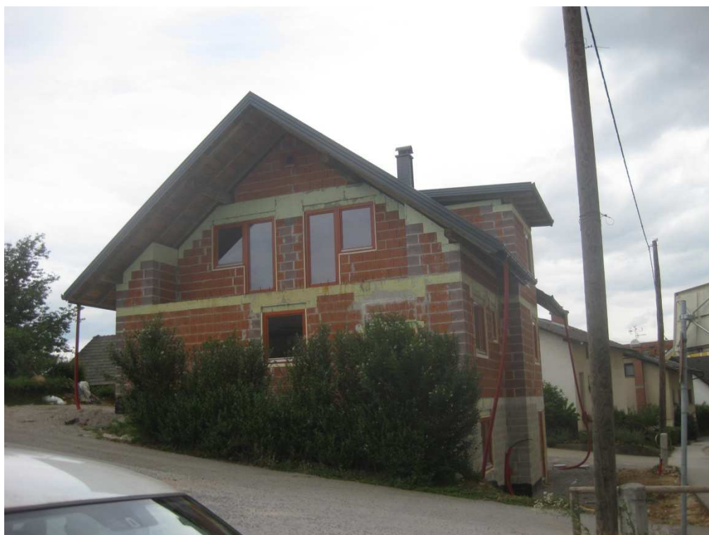
Fotografija 7: Pa08 – stanovanjska stavba Šmihel 8, Novo mesto
