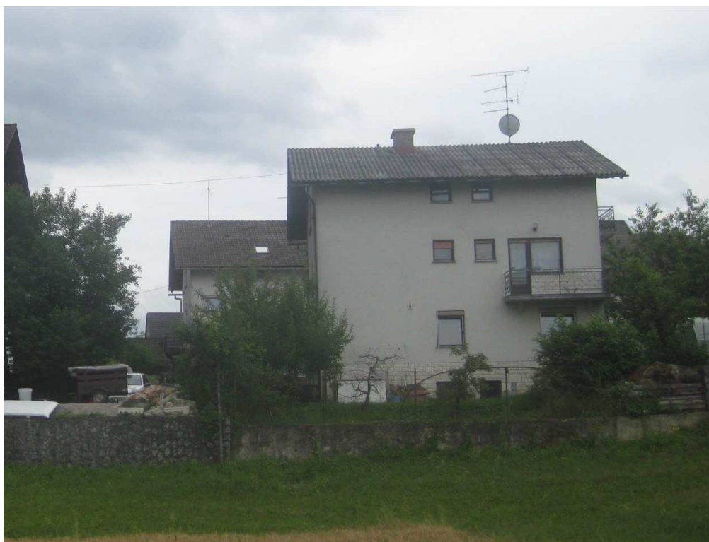
Fotografija 3: Pa03 – stanovanjska stavba Bajčeva ulica 10, Novo mesto
