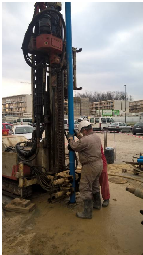
Slika 3: Cevitev vrtine V-E1-1/16
