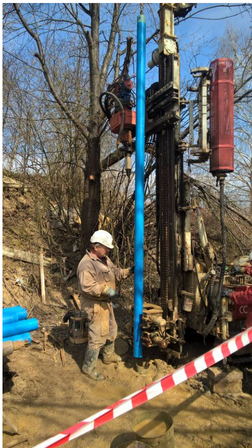
Slika 4: Cevitev vrtine V-E1-8/16 s plastičnimi cevmi
