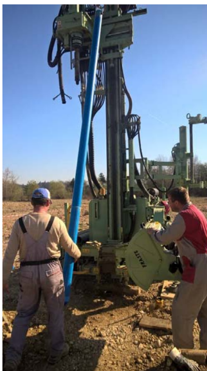
Slika 5: Cevitev vrtine V-E23-7/16 s PVC cevmi
