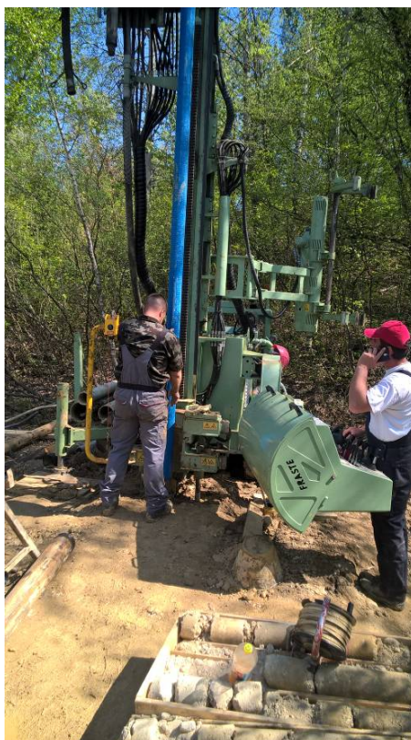
Slika 6: Cevitev vrtine V-E23-14/16
