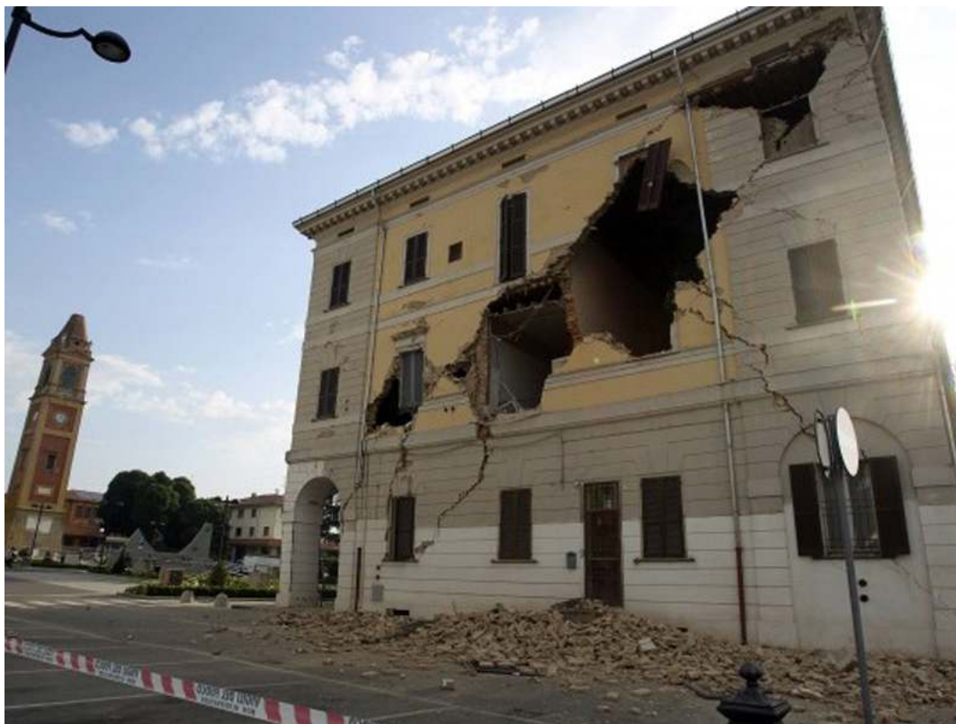
Slika 3. V potresu 20. maja 2012 pri Bologni je bila poškodovana mestna hiša v Sant'Augustinu (vir: http://www.flickr.com/photos/acanella/7260188756/sizes/c/in/photostream/ ).
