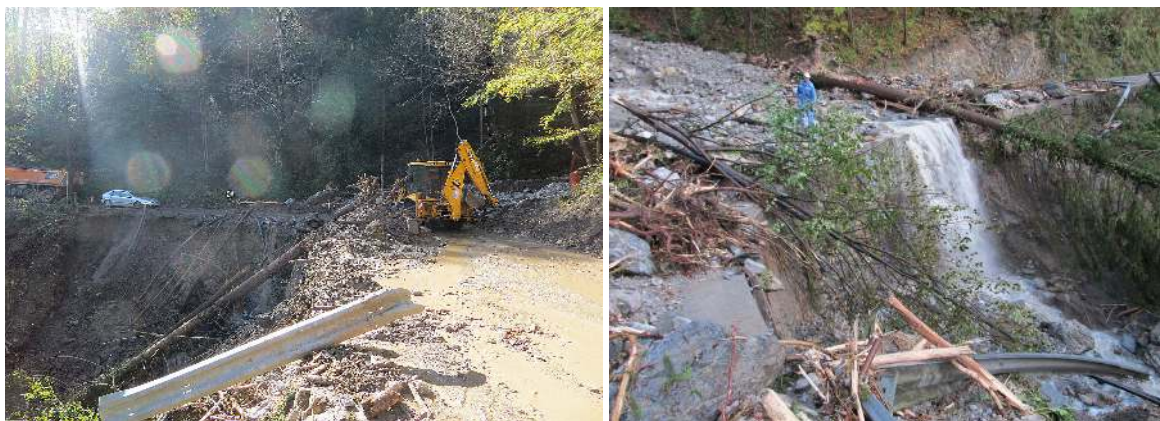
Slika 8. Hudourniške vode ob poplavah 22. oktobra so močno poškodovale ceste v srednjem Posočju (Vir: MMC). Figure 8. The flood damage on roads in Baška grapa (Photo: MMC)
