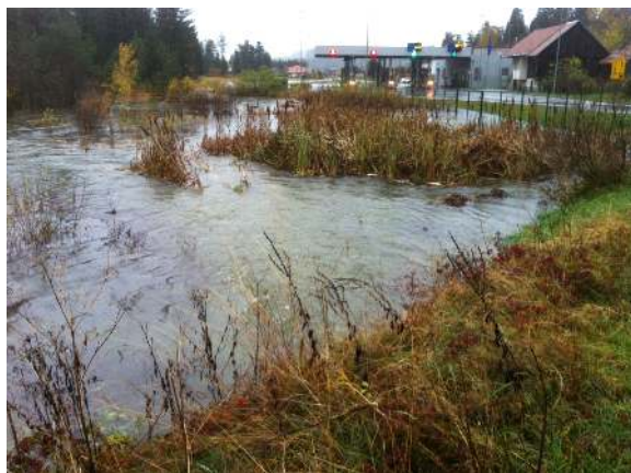
Slika 11. Med 6. do 8. novembrom je bil mejni prehod nad Babnim poljem delno zaprt. Voda je v tem času poplavljala cesto in posamezne objekte v Bukovici na Babnem polju (foto: krajan Prezid-a). Figure 11. The flood at the state border near Babno polje.
