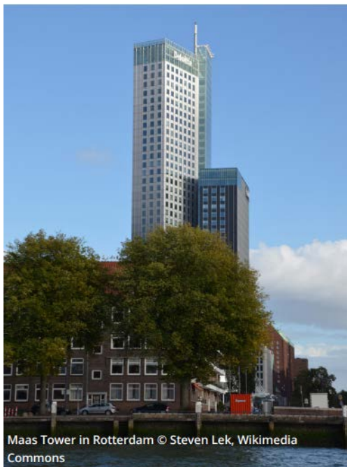
Slika 4. Stolp Maas v Rotterdamu – prenova je vključevala tudi učinkovit sistem za ogrevanje in hlajenje prostorov kar združuje prilagajanje in blaženje podnebnim spremembam
