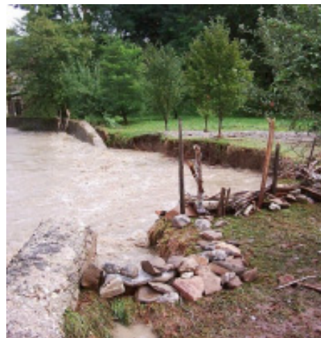
Slika 21. Podivjana voda je odnesla del brega (foto: Zorko Vičar) Figure 21. Damage left after the flash flood in Sevnica (Photo: Zorko Vičar)
