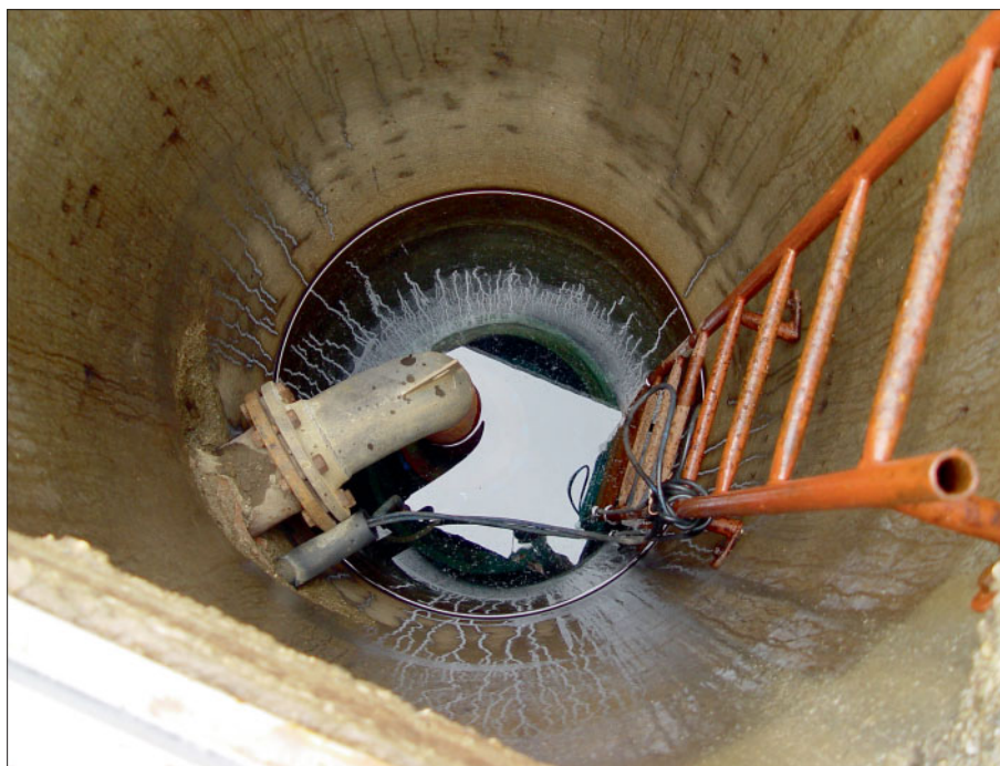
Črpalni vodnjak G črpališča podzemne vode Medlog v Spodnji Savinjski dolini (foto: Vlado Savič). Pumping well G of groundwater pumping station at Medlog in Spodnja Savinjska dolina (photo: Vlado Savič).
