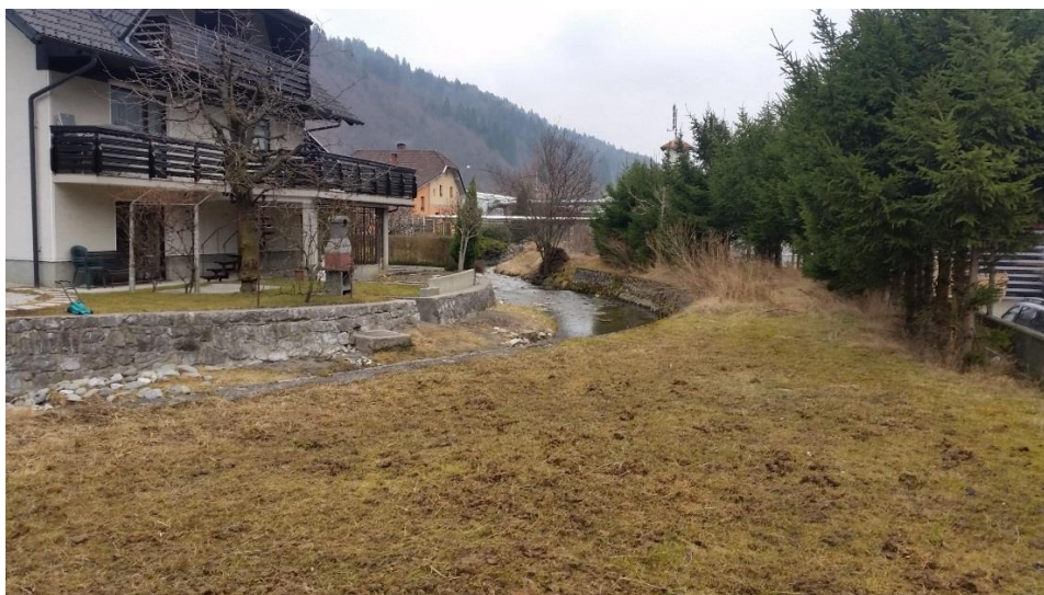
Slika 4: Območje na zaključku 2. odseka. Na desni strani je videti betonski zid, ki zmanjšuje poplavnost Alplesu
