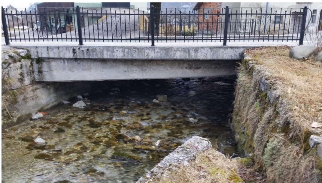
Slika 6: Gorvodna stran mostu (prepusta) preko Češnjice na regionalni cesti.
