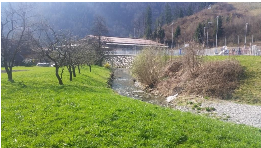
Slika 9: Območje sadovnjaka, kjer je predviden dvig terena (visokovodni nasip) za preprečitev poplavnega toka proti objektu Dašnica 3.
