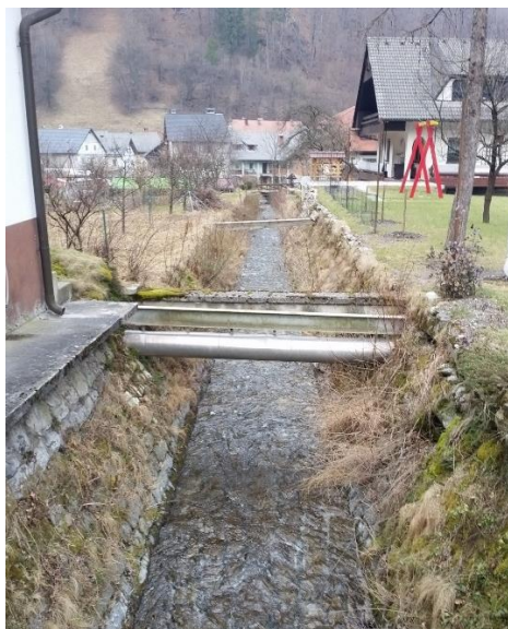
Slika 2: Tlakovan izlivni odsek Prednje Smoleve
