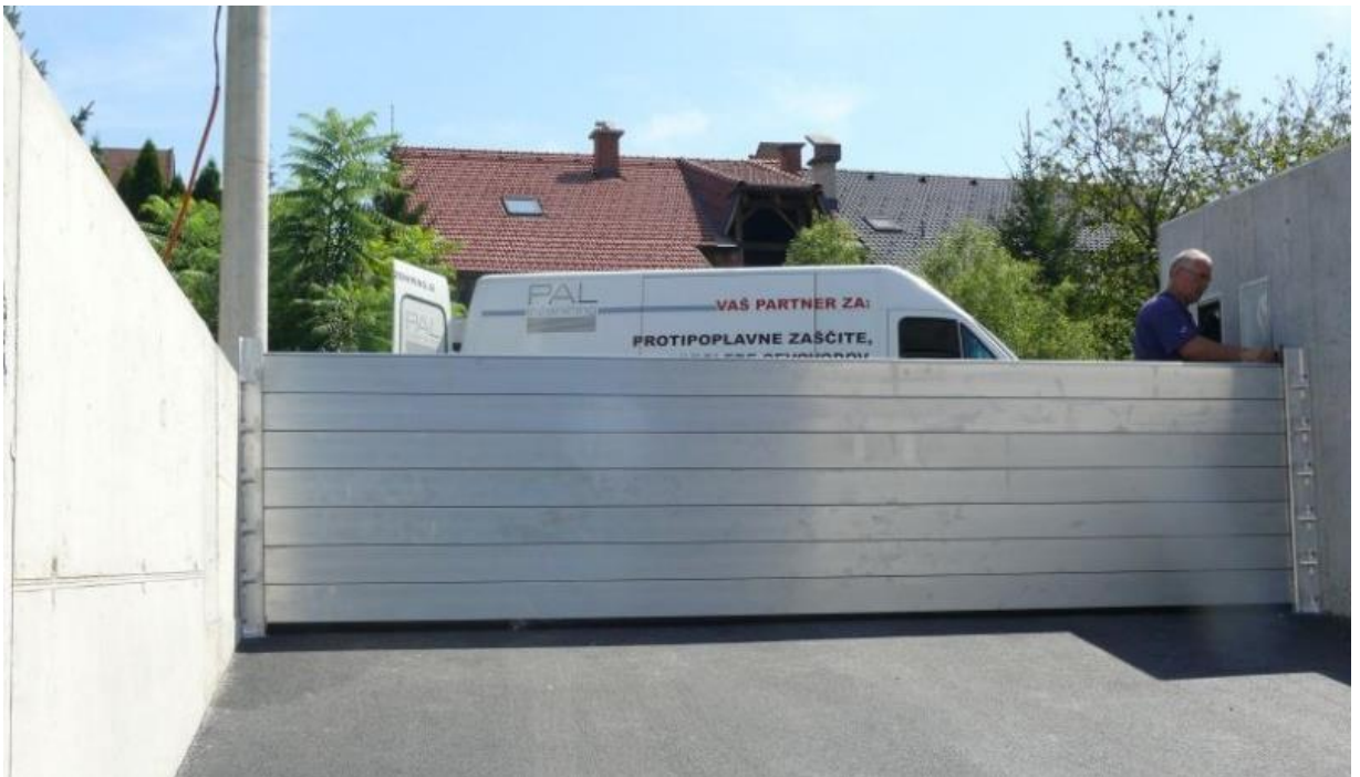
Slika 6: Primer montažne protipoplavne stene
