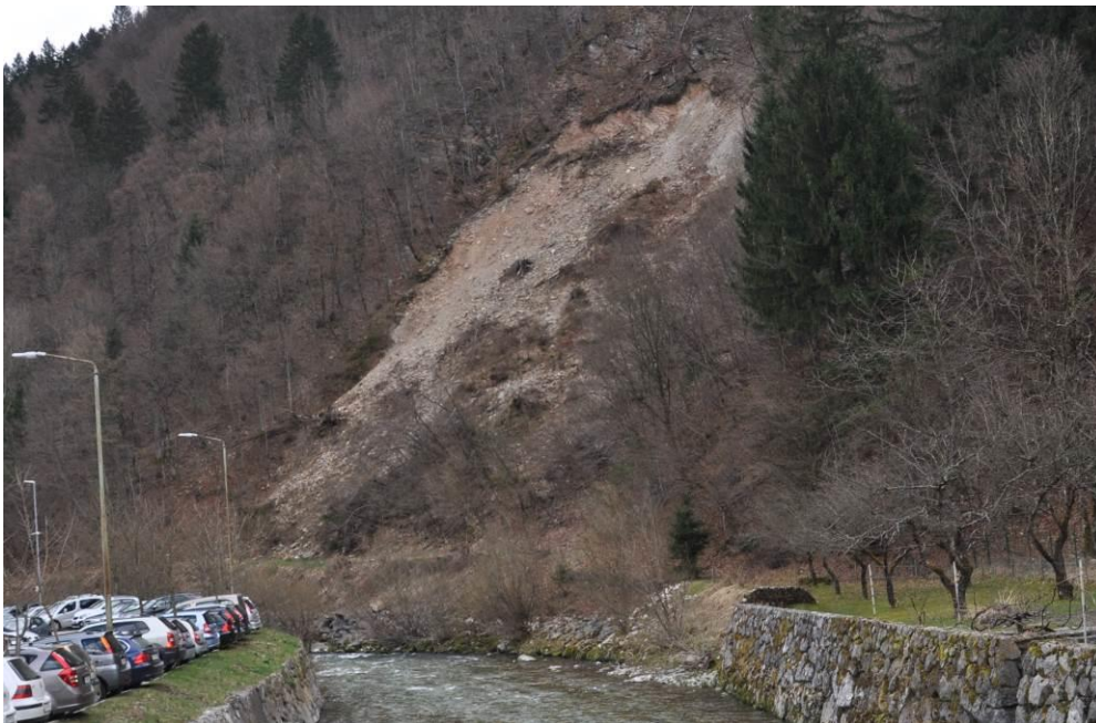
Slika 4: Območje plazu nad desno brežino pri Domelu
