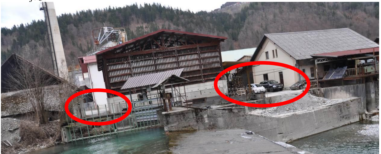
Slika 5: Lokaciji postavitve montažnih protipoplavnih sten ob Alpesovem jezua.
