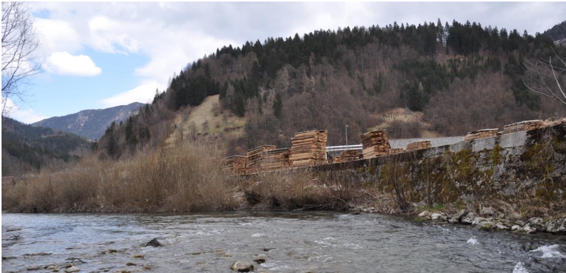
Slika 7: Obstoječi, v preteklosti že dograjevan VV zid ob levem bregu Sore.
