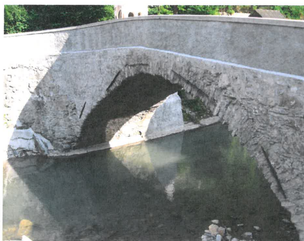
pogled na most z dolvodne strani – stanje 2011 (po sanaciji)
