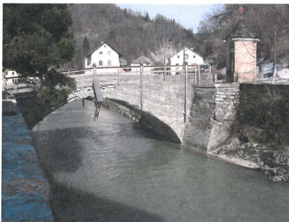
pogled na most z gorvodne strani – stanje 2009
