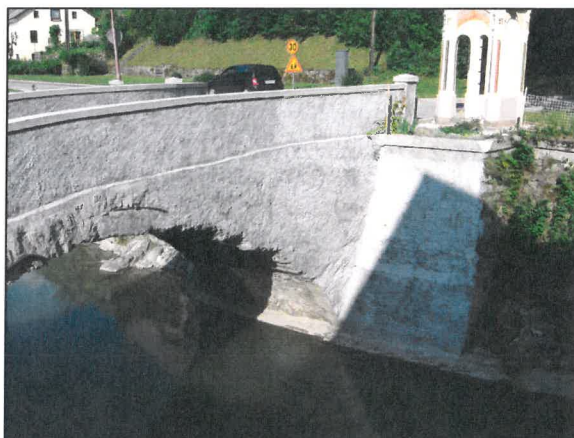
pogled na most z gorvodne strani – stanje 2011 (po sanaciji)
