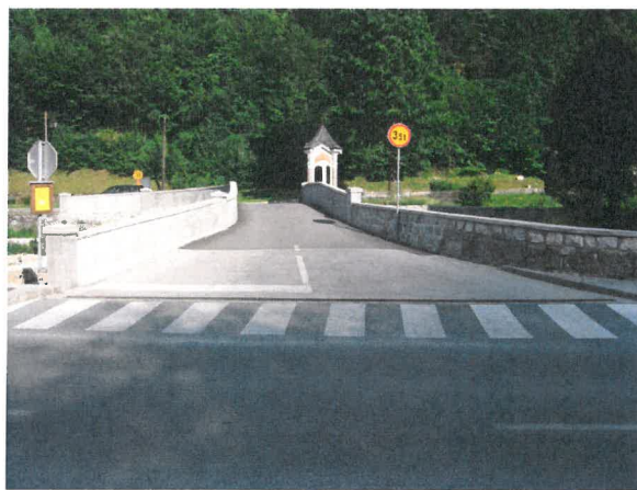
pogled na most v smeri Trnja – stanje 2011 (po sanaciji)
