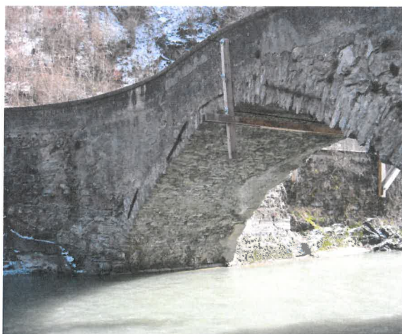
pogled na most z dolvodne strani – stanje 2009
