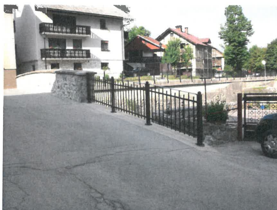
pogled na most v smeri regionalne ceste – stanje 2011 – popravilo ograje
