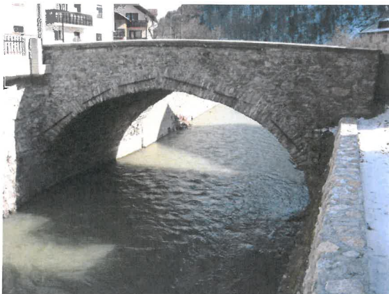
pogled na most z gorvodne strani
