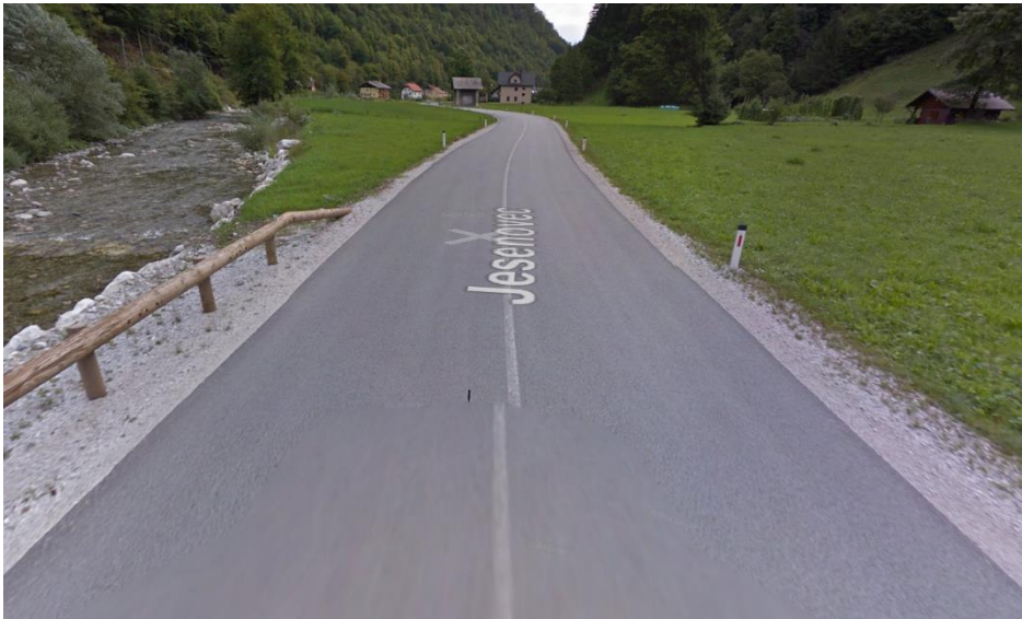
Slika 2 – obstoječa regionalna cesta na območju visokovodnega nasipa
