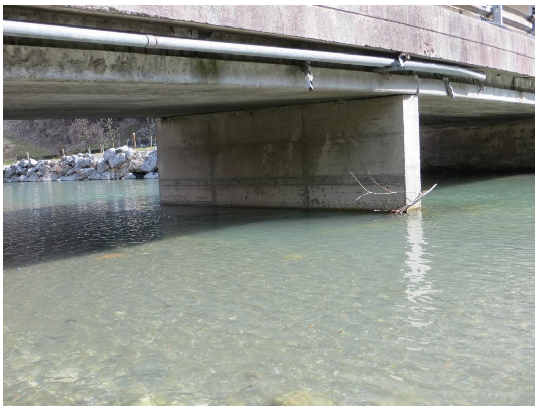
Slika 4: vmesni opornik (gorvodna stran)
