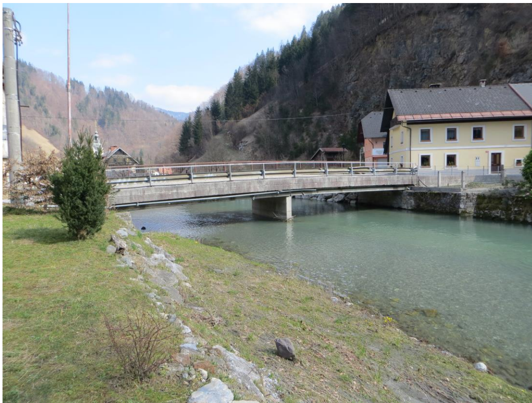
Slika 3: gorvodna stran mostu (pogled proti desnemu bregu)
