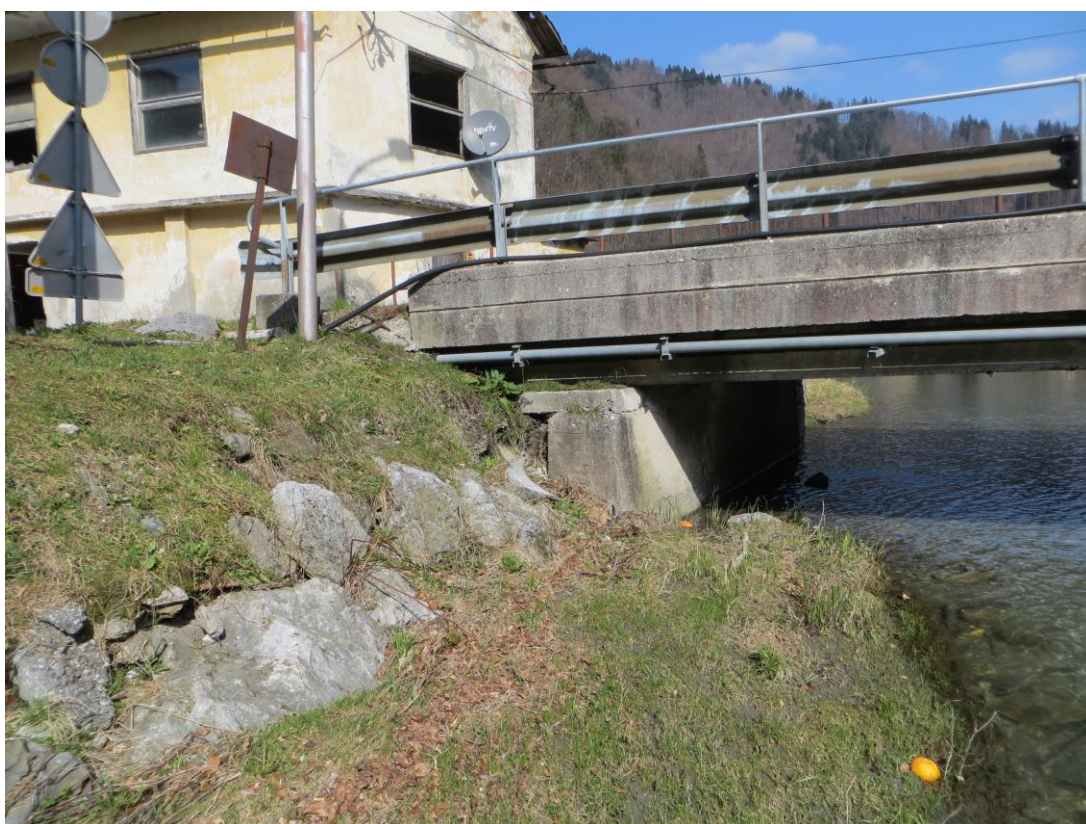
Slika 2: levobrežni opornik
