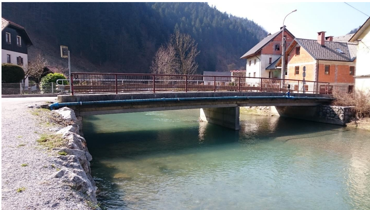
Slika 1: dolvodna stran mostu (pogled proti levemu bregu)
