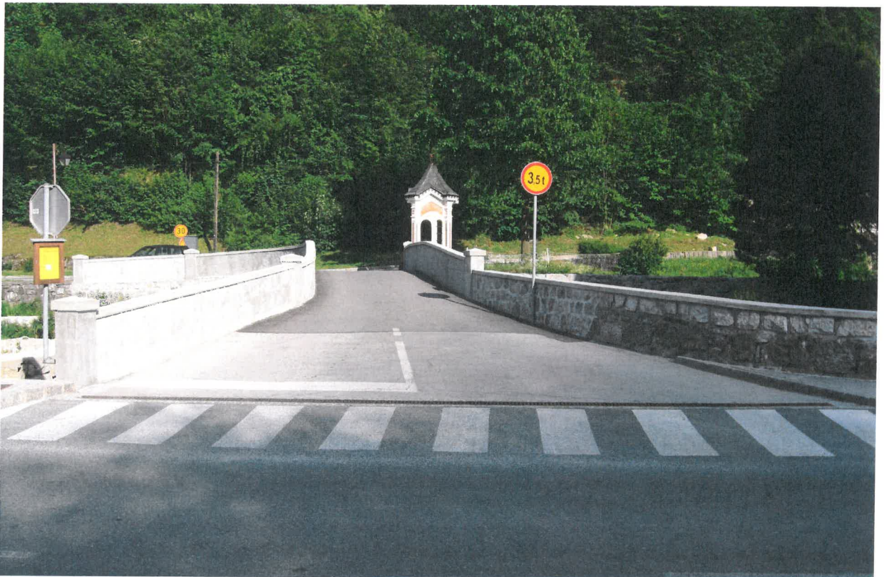
slika 2 : pogled na voziščno konstrukcijo mostu - smer Trnje
