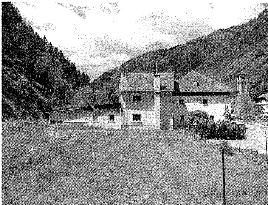
Slika 14: vzhodna stran stanovanjskega objekta
