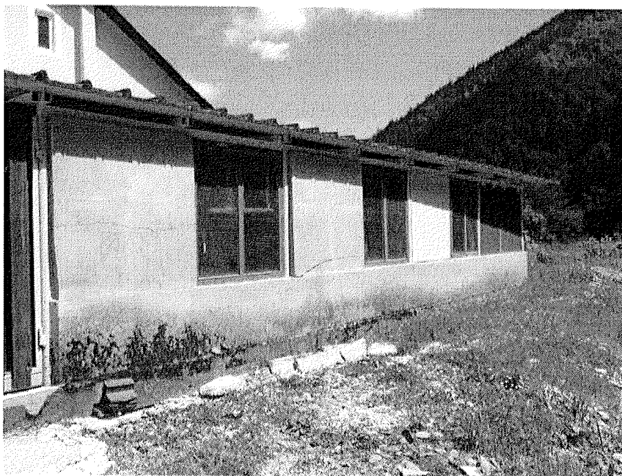
Slika 17: južna stran prizidka - objekt 4c
