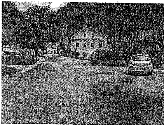
Območje zahodnega priključka v km 7+790
