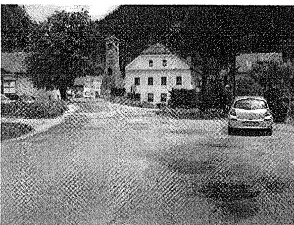
Območje zahodnega priključka v km 7+790
