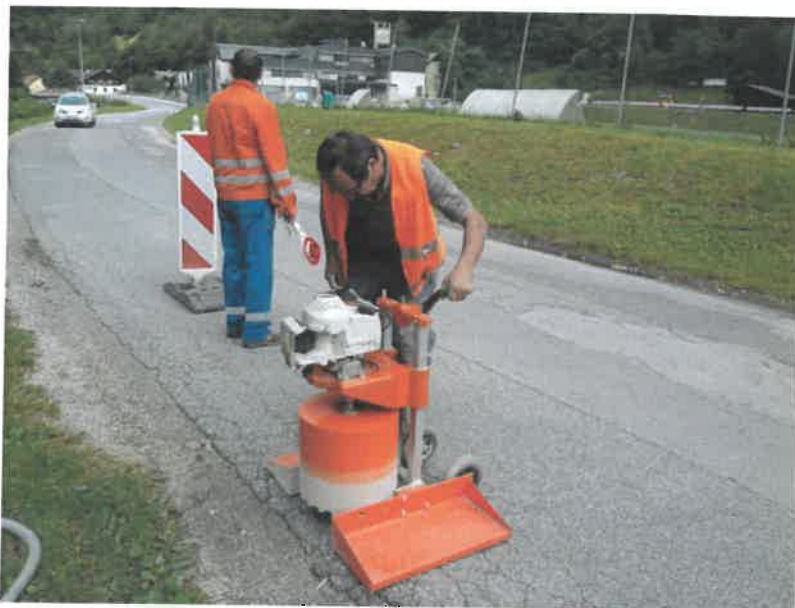
Izdelava vrtine – jaška J-2 na vozišču.
