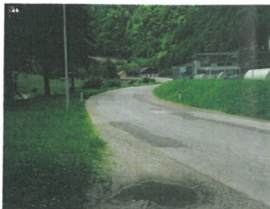
Območje zahodnega priključka v km 7+790
