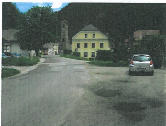
Območje zahodnega priključka v km 7+790
