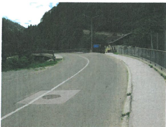
Začetek obravnavnega odseka v km 7+658 (na koncu mostu preko Selške Sore)
