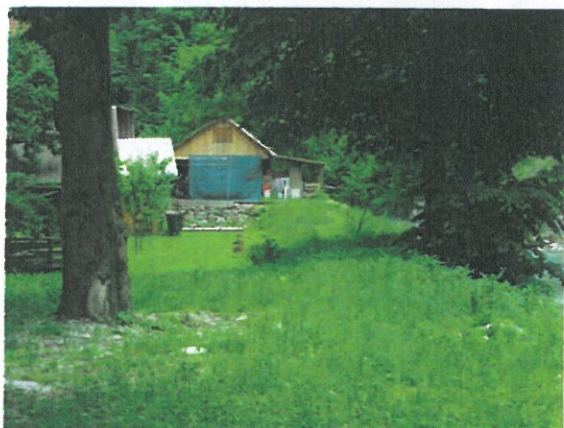
Območje nove trase ob strugi Sore – objekti za odstranitev
