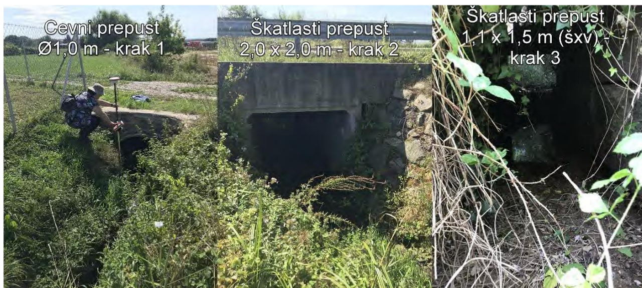
Slika 31: Obstoječi prepusti (vir [26])
