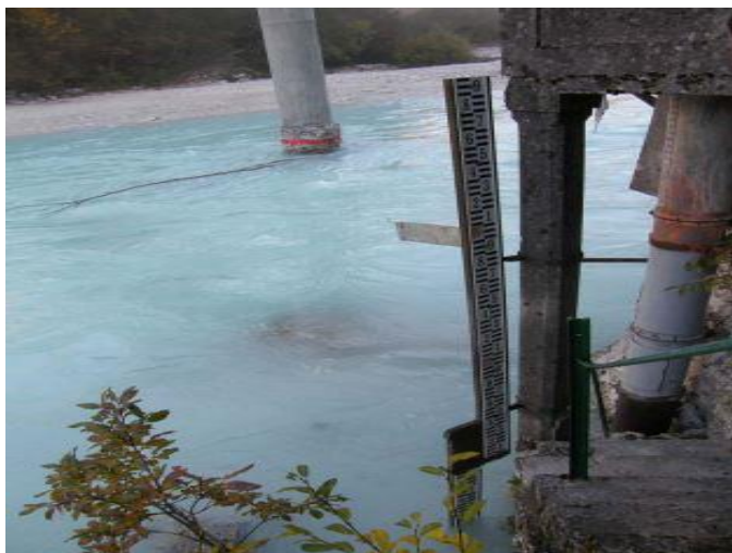
Slika 4. Na stebri mostu (levo na sliki) je vidno mesto, do kjer je bilo zaprodno dno v času gradnje mostu, ki se je pričela leta 1972 (vir: arhiv ARSO).
