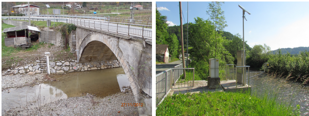
Slika 3: Izvedba novih avtomatskih merilnih mest na v.p Branik (leva slika) in na v.p. Zminec (desna slika) (foto: Marko Burger)
