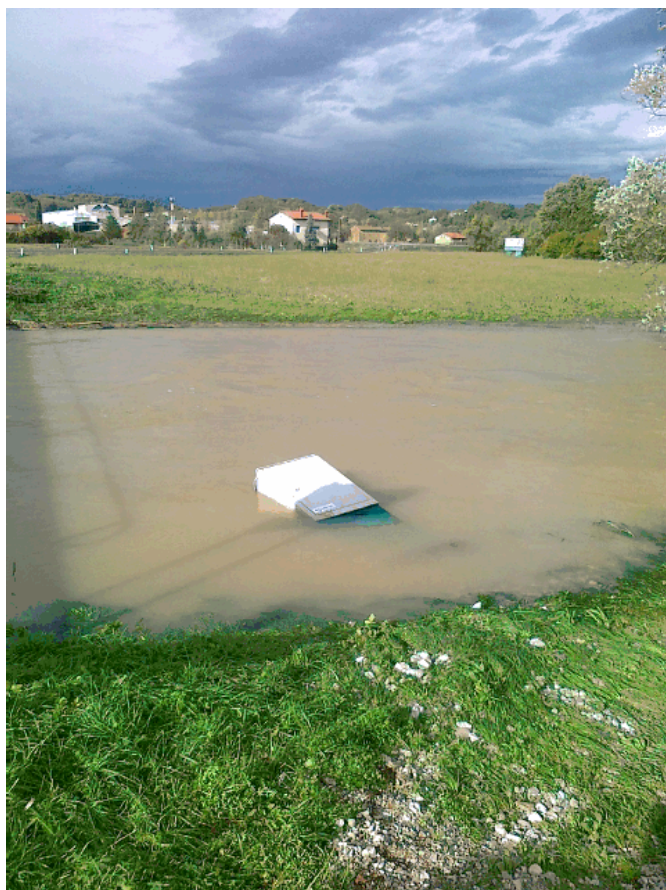
Slika 24: Porušitev vodomerne postaje na Lijaku v poplavnem valu iz 27. na 28. oktober 2012 (foto: Miha Tominc)
